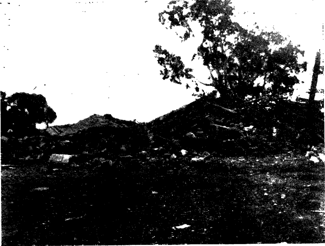
انقاض بعض منازل الفلاحين السوريين التي نسفتها القوات اليهودية أثناء اعتدائها يوم ١١ ديسمبر سنة ١٩٥٥
